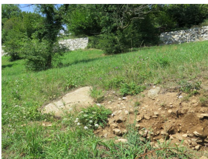
Freigelegter Sandboden in einem Hang. (Vogelrüti)
