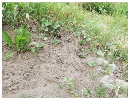
Abbruchkante, die freigehalten wird.
