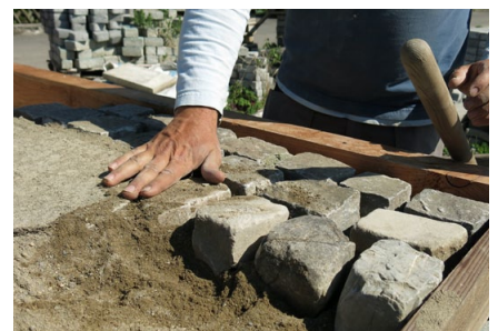
Wegplatten werden mit Sand befüllt.
