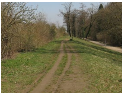
Naturweg auf einem Hochwasserdamm.
