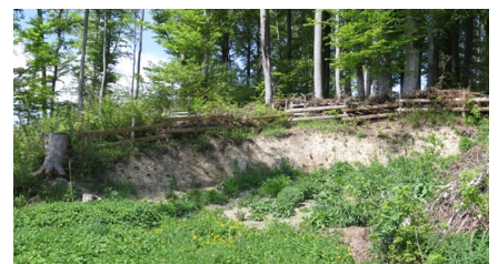
Eine alte Grube wurde freigelegt und ist wieder ein beliebter Nistplatz. (Bannholz, Naturpark Gantrisch BE)
