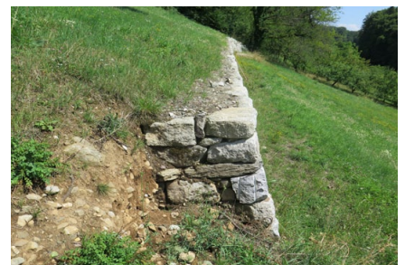
Abbruchkante vom Trockenmauerbau. (Vogelrüti AG)
